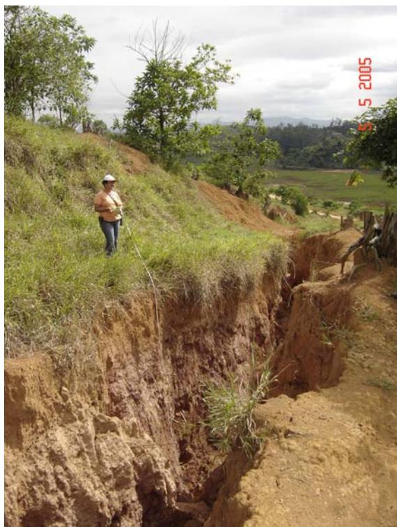
3 – Sério processo erosivo com exposição do horizonte C em um corte inadequado de talude para construção civil no **ponto 24** que ameaça, inclusive, as edificações na alta vertente.
