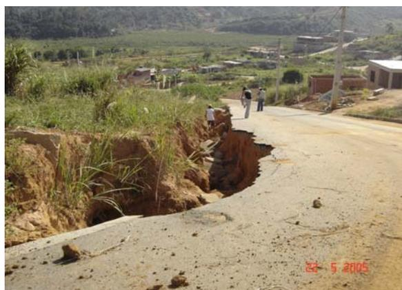
Localmente pode-se observar que no horizonte **C** ocorre formação de erosão tubular ou *piping*.
